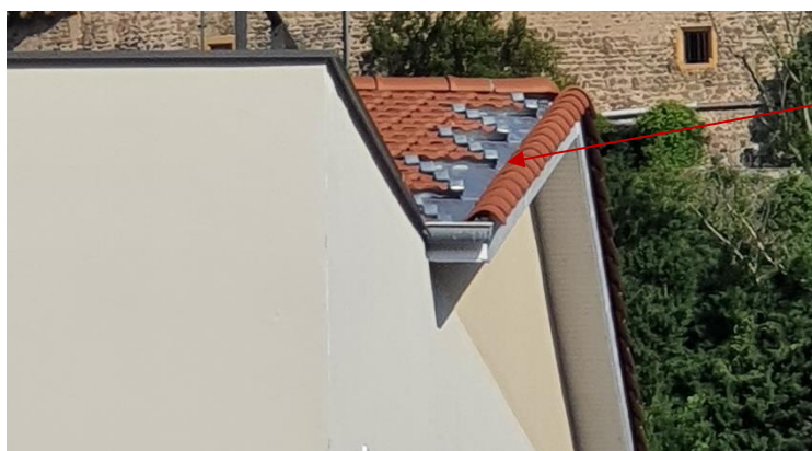
Type de « finition » de toiture interdite »
