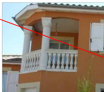
Type de balustres interdites
